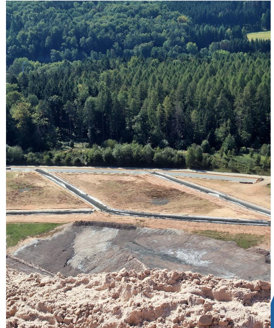
Haldeninterne Entwässerungselemente, 2. BA (Scoop 21.10.2020; 09.11.2021)
