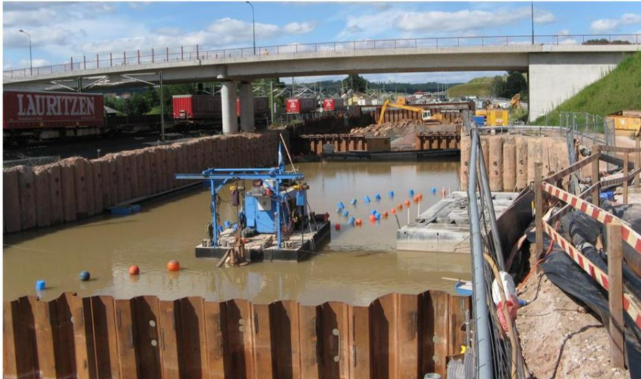
Das bauliche Meisterstück des Tunnels wurde im Bereich der Zollwegbrücke umgesetzt. Hier mussten die Gründungsarbeiten unterhalb des Grundwasserspiegels ausgeführt werden.
